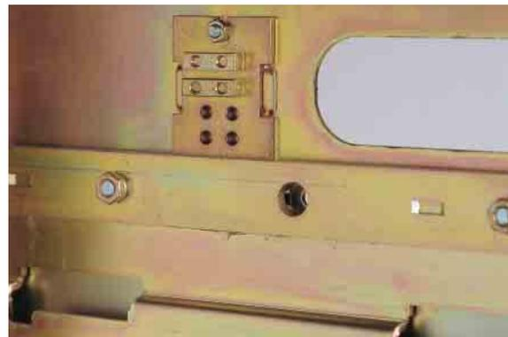
Это устройство не позволяет вставлять автоматический выключатель в кассету автоматического выключателя другого номинала.
