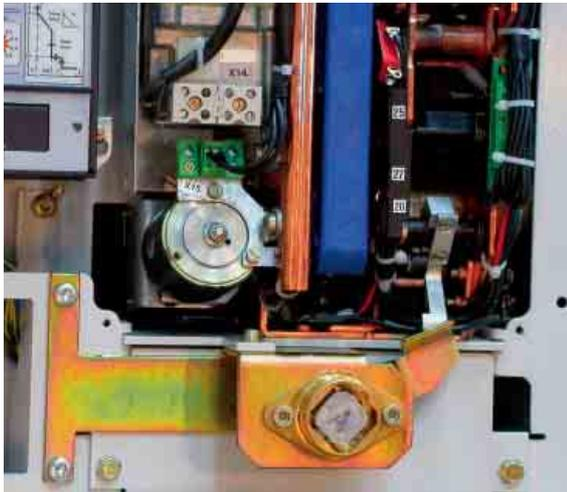
Устанавливаемые в автоматический выключатель устройства бокировки такие как Castell, Ronis, Profalux и Fortress. Эти устройства блокируют включение выключателя пока в замок не будет вставлен специальный ключ.
